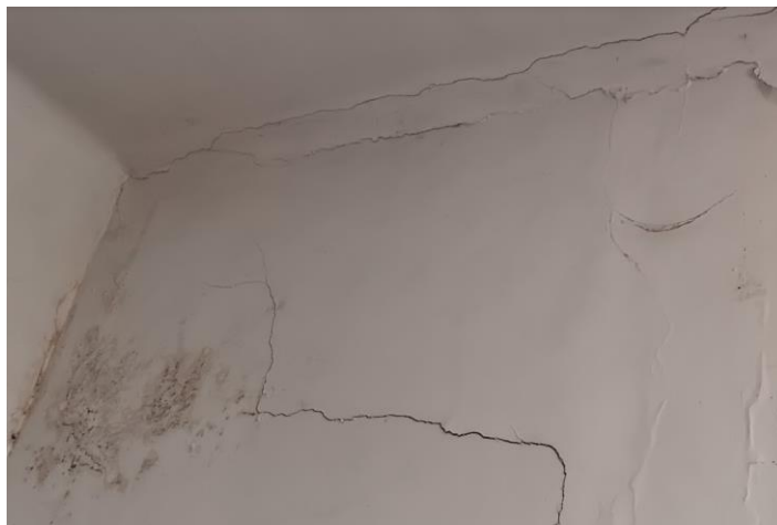
Zawilgocone tynki sufitu i ścian, wykwity pleśni , odspojone, łuszczące się warstwy farb a także pęknięcia ścian
