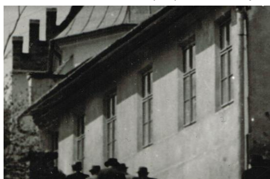
Zdjęcie z 1956 r – widać okna w elewacji południowej, dzielone w poziomie na trzy, z profilowanym ślimieniem. Na zdjęciu obok obecne okna w tej samej lokalizacji.
