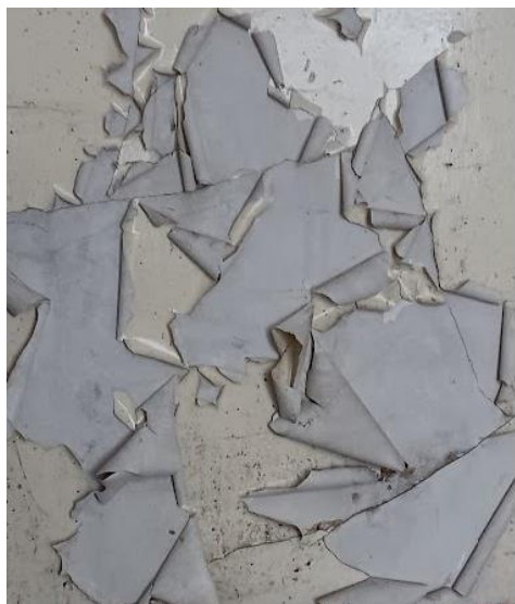
Zawilgocone tynki sufitu i ścian, wykwity pleśni , odspojone, łuszczące się warstwy farb a także pęknięcia ścian
